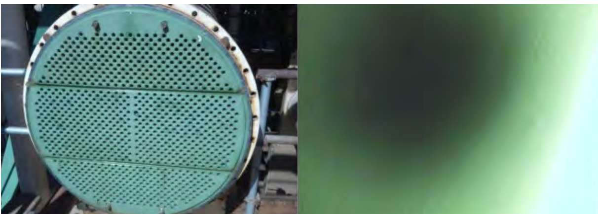
Figura 13. Osservazione visiva ed endoscopica di un fascio tubiero rivestito
