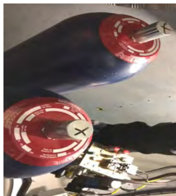
Figura 3. Fotografia di due accumulatori idraulici installati all'interno della navicella di un aerogeneratore del Parco eolico di Mazara del Vallo (prov. TP), eseguita dagli autori
