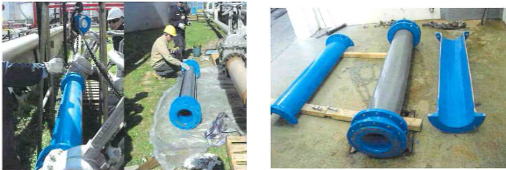
Figura 7. Ispezione visiva interna ed esterna del pezzo campione disassemblato, costituito con stesso lining protettivo installato nella sea line (fonte: Liner integrity management - Primus Line 230041)
