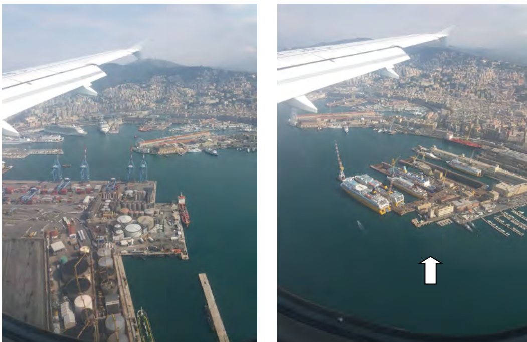
Figura 1. Vista aerea del Porto di Genova: sulla sinistra gru portuali e serbatoi; sulla destra il punto nel quale era posizionata la Torre Piloti prima del crollo. [11]
